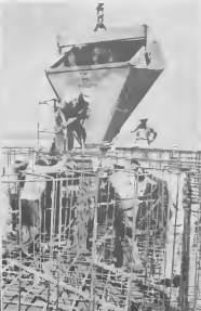
TRES TRUCK Read-Mix a tene hoppers di concreto, ariba, continuamente yen den e trabao cu a dura for di manta tempran te cu drentada di solo. Despues cu un hopper di dos yarda cubico a worde yena, handa robex, e ta worde zecwani pa e dolfin cu e grua grandi di Raymond, robex mas abao, y basha den e base reforza di stal.
